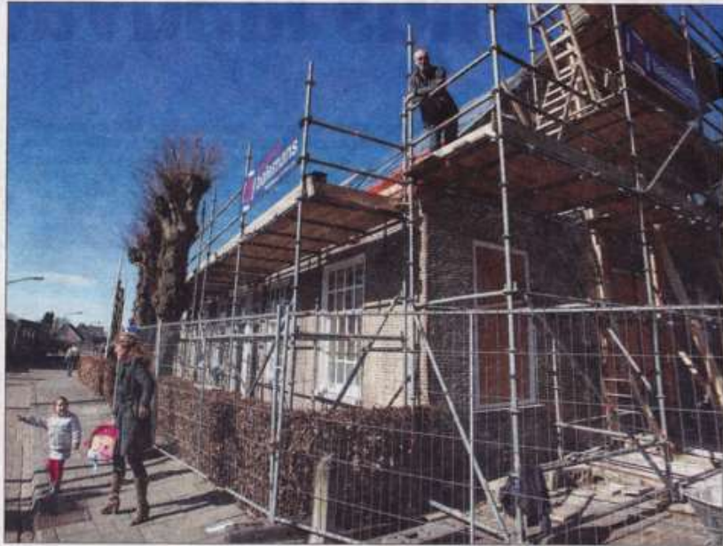
■ Guido Haffmans (op de steiger) uit Dorst zag op nieuwjaarsdag zijn monumentale boerderij, waaraan hij zeventien jaar lang had gewerkt, in vlammen opgaan. Maar het pand is nog te redden: momenteel wordt er hard gewerkt om de boerderij weer in de oude staat te herstellen. foto Ron Magiels/het fotoburo
