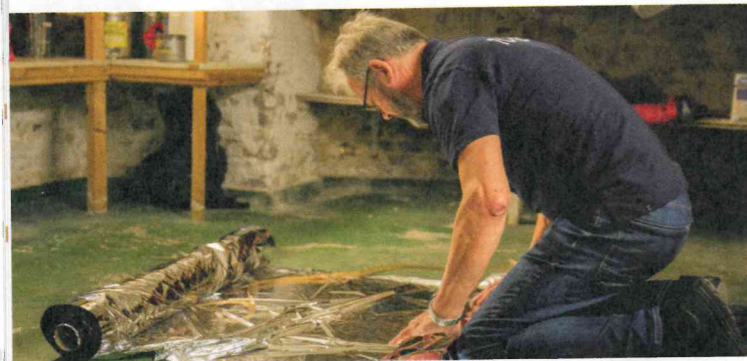
Ton bezig met vloerisolatiesysteem in een woning in Maastricht
